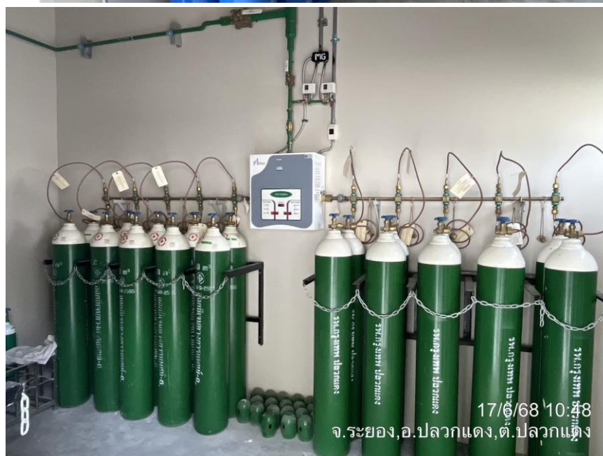
รูปที่ 2-19 ระบบถังท็อก๊าซที่ใช้ในการแพทย์
